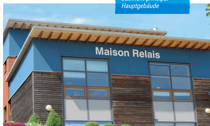
Bâtiment principal Hauptgebäude
