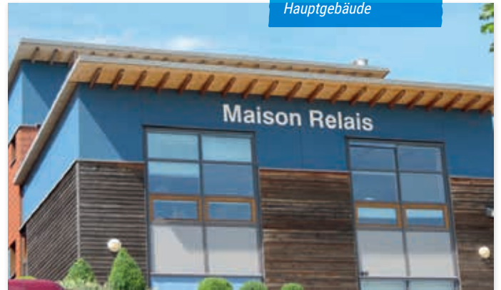
Bâtiment principal Hauptgebäude
