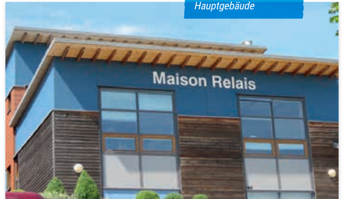
Bâtiment principal Hauptgebäude
